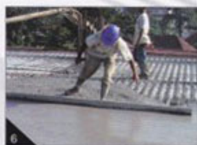
Ratakan cor-an untuk mendapatkan permukaan yang rata
