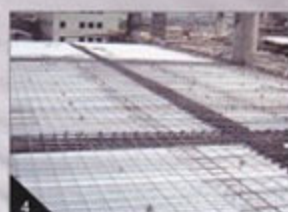
Pasang tulangan sesuai kebutuhan.
