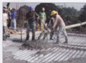
Tuang cor-an pada lokasi yang tepat
