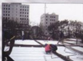
Pasang ABADIDECK® pada konstruksi beton atau baja. Aplikasikan material end stop, jika dibutuhkan.
